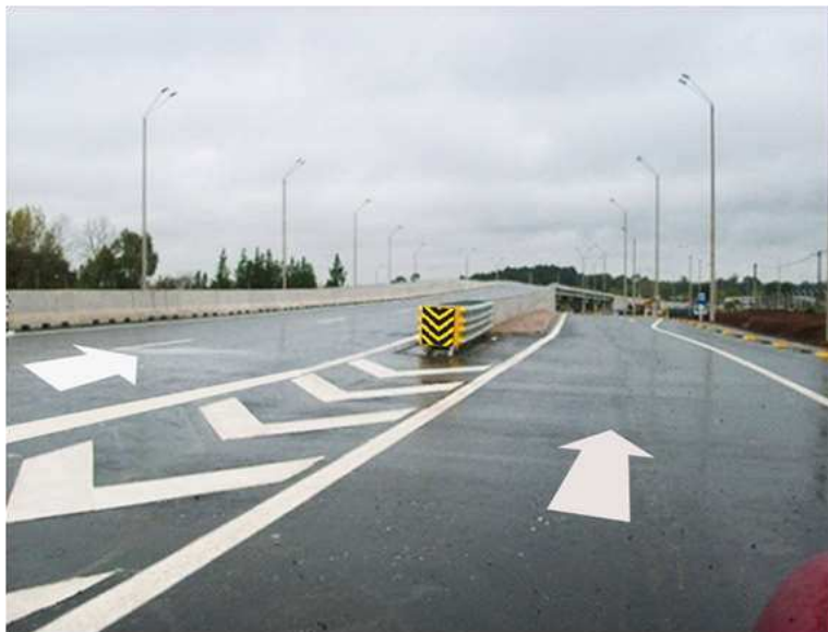
Fotografía 4.8 Amortiguador terminal para barrera de seguridad
