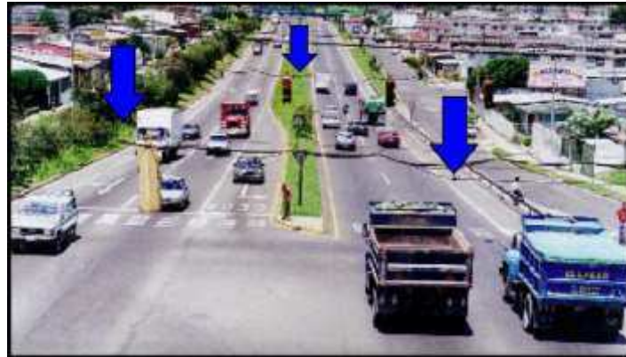
Vía rápida con isla separadora central y con islas laterales para separar la vía principal de las calles marginales. Fotografía 4.2
